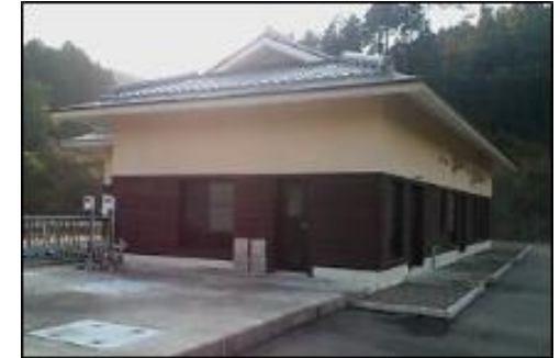
中溪浄化センター
