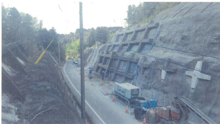
のり面補修工事（平成30年12月18日）
