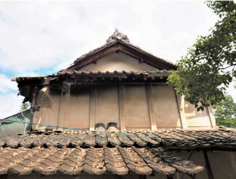
02 漆喰塗り込めの南東面の壁
