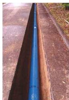
老朽管の耐震管への布設替工事
