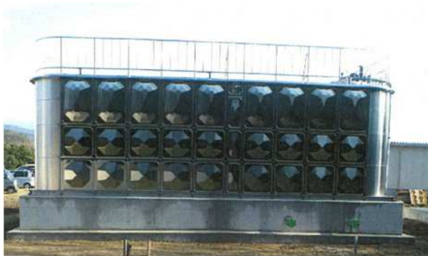
中の原配水池
