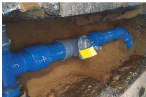
老朽管の耐震管への布設替工事
