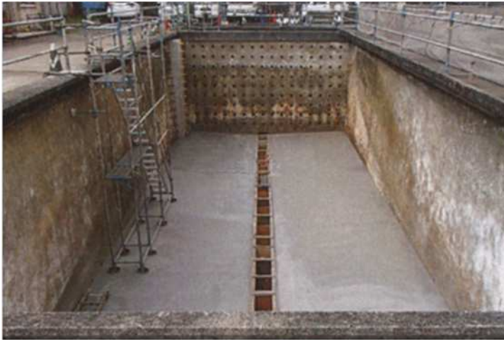
杵築浄水場の沈殿池耐震化工事
