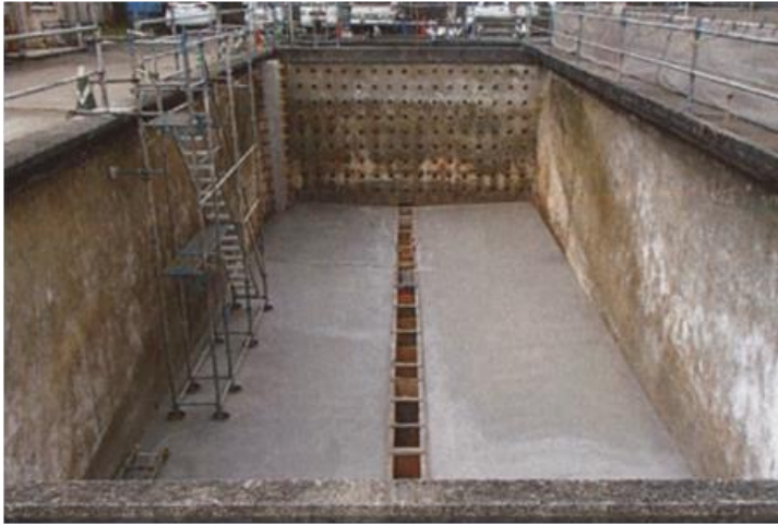
杵築浄水場の沈殿池耐震化工事
