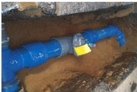
老朽管の耐震管への布設替工事
