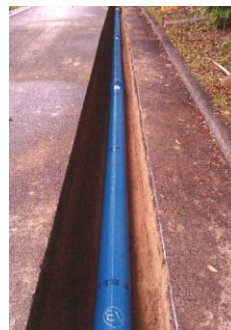
老朽管の耐震管への布設替工事
