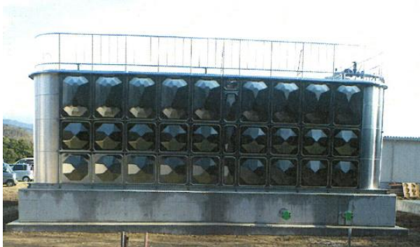
中の原配水池
