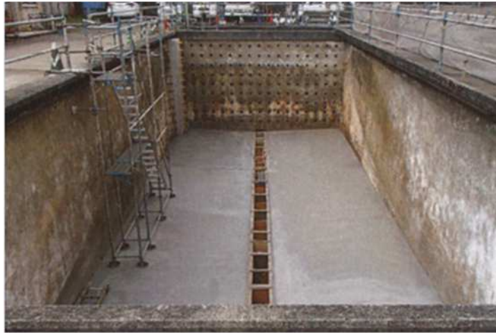
杵築浄水場の沈殿池耐震化工事
