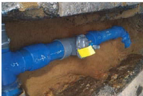
老朽管の耐震管への布設替工事
