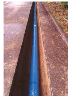
老朽管の耐震管への布設替工事
