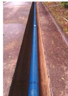
老朽管の耐震管への布設替工事
