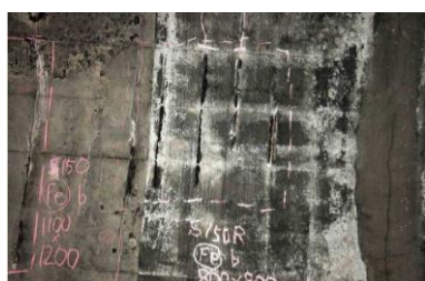
写真-2.4 鋼材腐食
