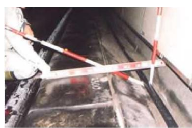
写真-2.3 変形・移動・沈下
