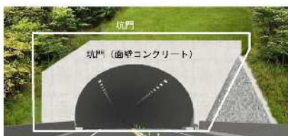
参図-2 点検対象箇所（トンネル坑口部）
