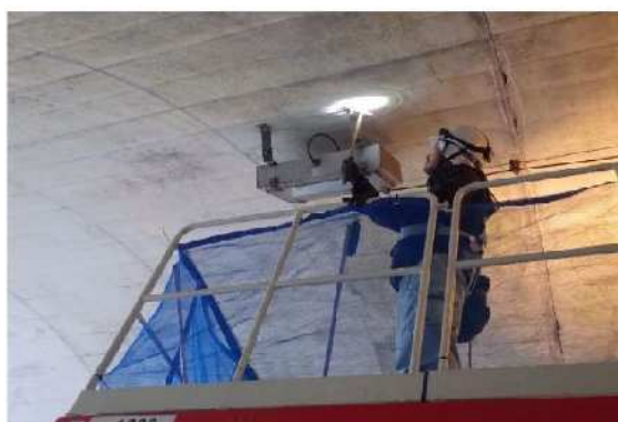
写真-4.2 附属物点検状況
