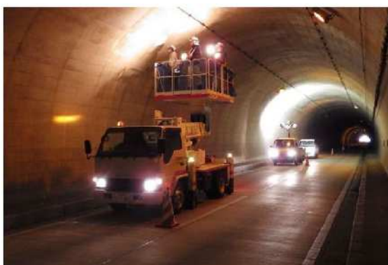
写真-4.1 点検状況
