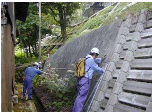
<斜面構造物の調査状況>
