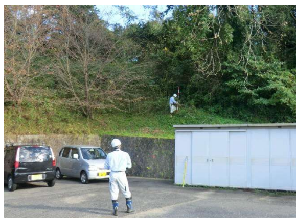
<崖地の調査状況>
