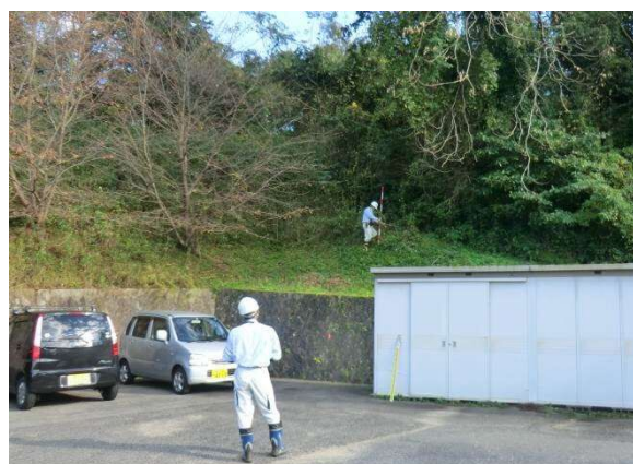
<崖地の調査状況>
