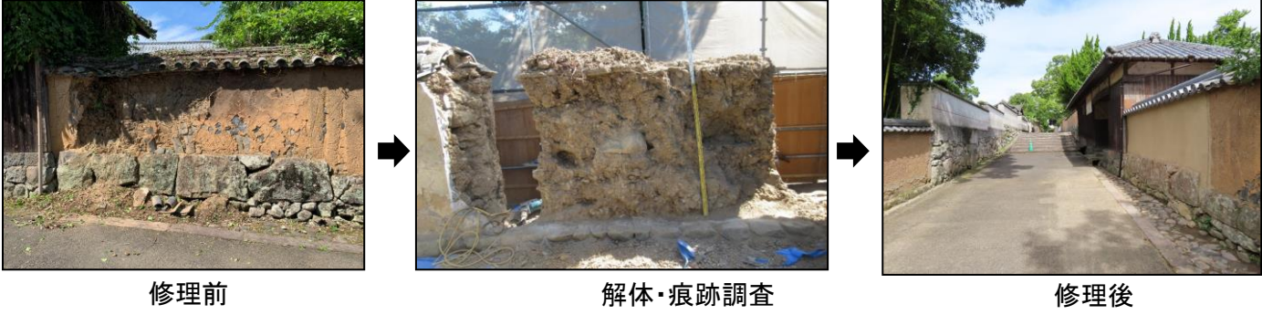
【① 工11-1の土塀修理工事】
