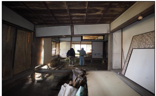
【旧田嶋家保存調査の様子】
