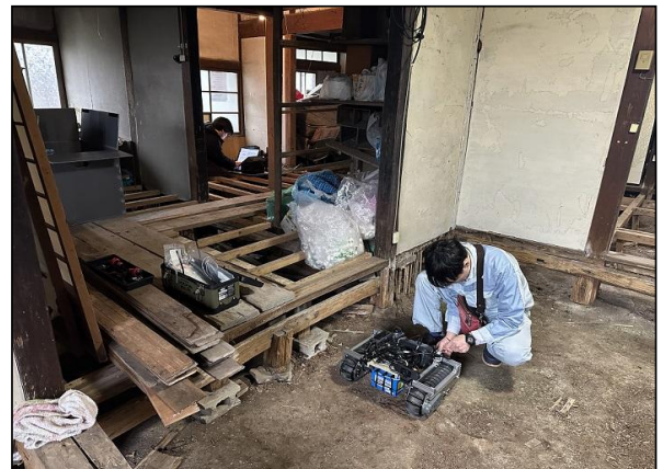
【超音波伝播速度測定(非破壊試験)の様子】
