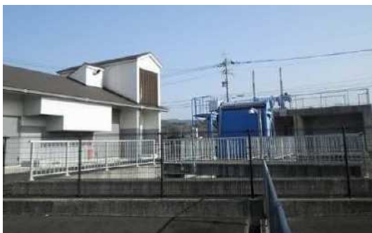
錦城雨水ポンプ場
