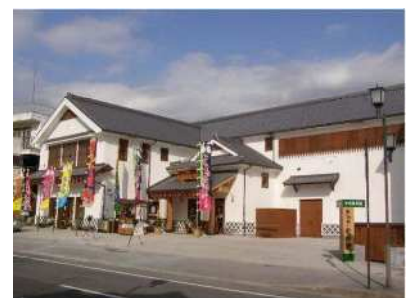
きつき衆楽観(古民家活用)
