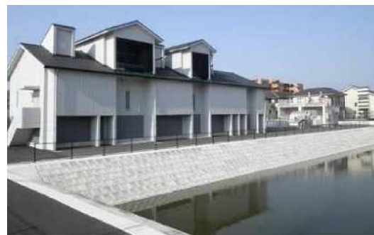
北浜雨水ポンプ場
