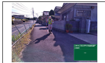
写真15 盛土境界部付近
