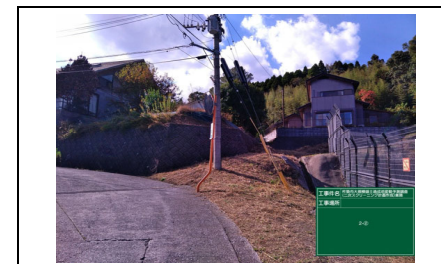
写真4 盛土境界部付近
