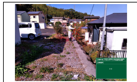
写真7 盛土境界部付近
