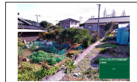
写真8 盛土境界部付近
