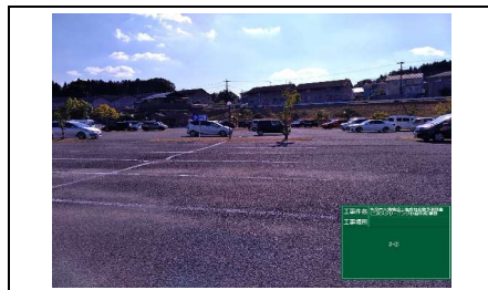
写真10 盛土中央部(土地利用状況)
