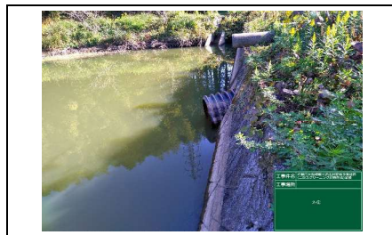
写真2 盛土下端部(末端先) ため池の排水管
