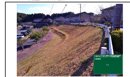
写真16 盛土境界付近
