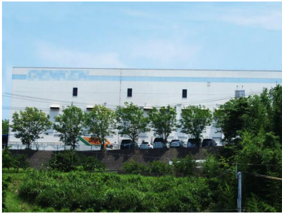
【里のゾーン】敷地境界部に樹木を植樹することで、建築物の長大な壁面による圧迫感を軽減しています。
